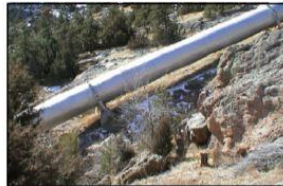
Actual Slope of Project Site
