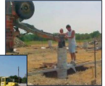
Level work area, layout and pour 10 piers.
