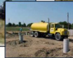
Level work area, layout and pour 10 piers.
